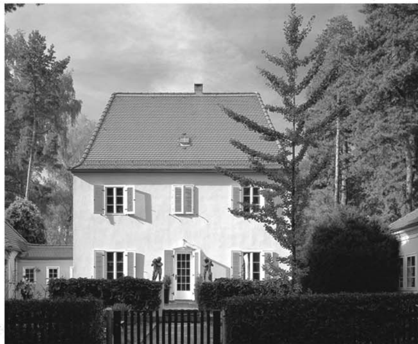
Hellerau, Heideweg 24. Eine von Heinrich Tessenow 1910/11 nach dem Vorbild von Goethes Gartenhaus in Weimar erbaute Doppelhaushälfte.
